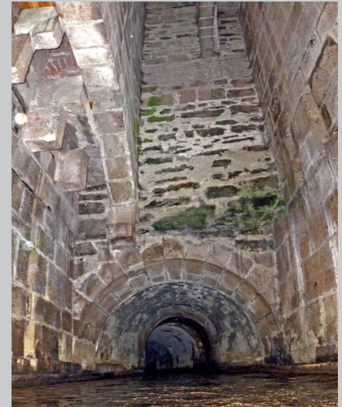
Královská štola se záchodovou šachtou v nemocničním křídle nového konventu. (Foto J. Řehák jr., 2013)
