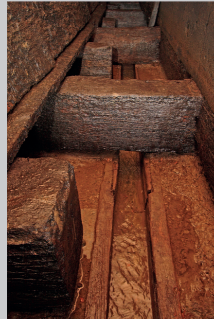
Pohled na základový rošt pod novým konventem v průběhu čištění. (Foto S. Kročáková, 2011)
