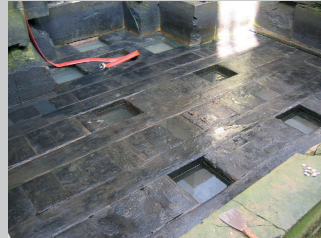
Čištění bazénů určených pro sledování úrovně hladiny vody pod konventem. (Foto P. Duchoň, 2005)
