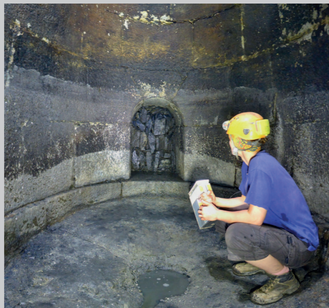
Pohled do vytěžené barokní záchodové jímky v areálu prelatury, v níž byly při dně objeveny dvě protilehlé zaslepené štoly plánované kanalizace. (Fotoarchiv Řehák – SPELEO, s. r. o., 2017)
