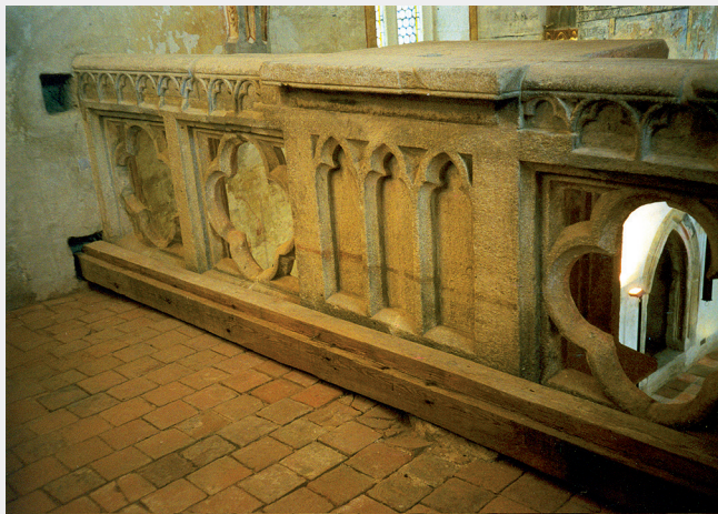
Parapet s kružbami na tribuně včetně oltáře. (Foto P. Malinský, 2001)
