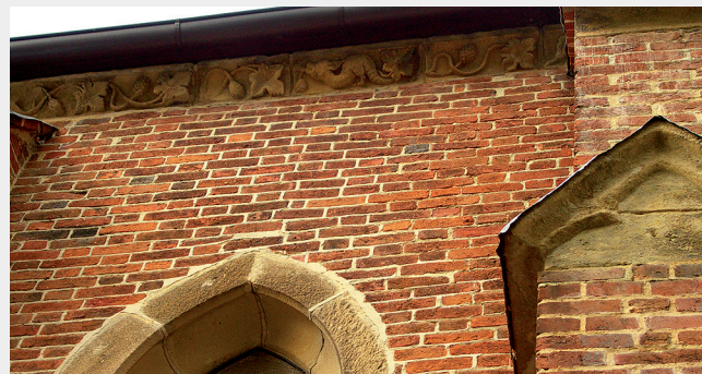
Detail horní části jižní fasády s hlavní římsou s rostlinnými a zvířecími reliéfy.
