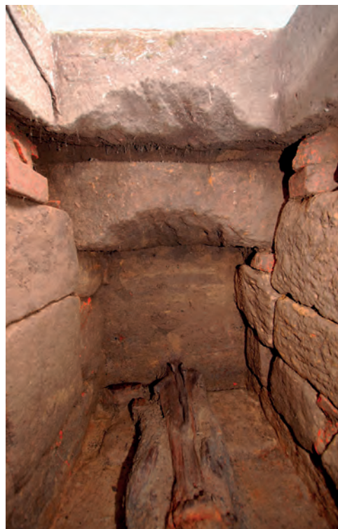
obr. 22_Východní profil sondy S06 v průběhu exkavace tvořený zakončením revizní šachty směrem k tělesu kašny. V horní partii snímku jsou viditelné stopy po přitesání spodních hran kamenné obruby a překladu. Dřevěné potrubí pokračuje směrem pod těleso kašny a je převrstveno zásypem z postupně se ukládajících uloženin. Foto autorka, 2014
