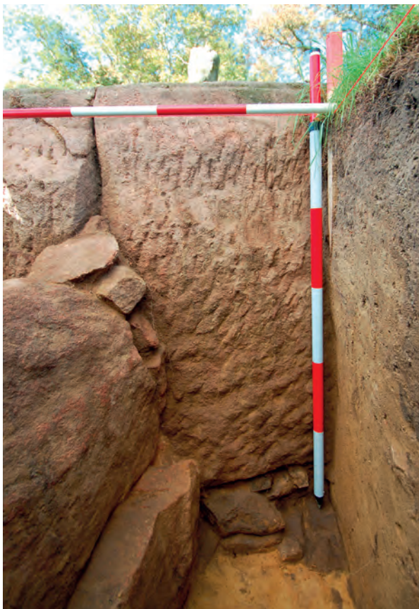
obr. 9_Detail západního profilu sondy S01 tvořeného vnějším pláštěm kamenného tělesa kašny s pozorovatelnou horizontální vyrovnávkou z drobných šíbrů pod vnější hranou dna. V levé části snímku pak konstrukce kamenných bloků s jílovou omazávkou na stykové ploše s kamennými segmenty v místě vertikální spáry.
