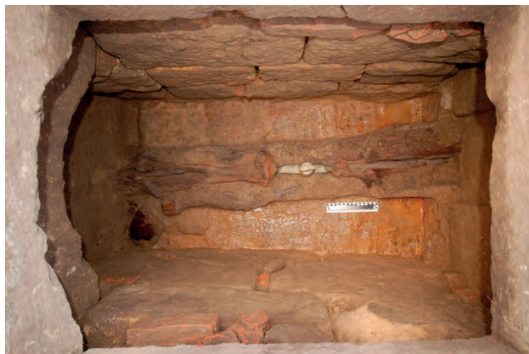
obr. 19_Půdorys sondy S06 po dokončení exkavace se znatelným průběhem dřevěného potrubí na dně revizní šachty v hloubce 1,4m. Ve střední části konstrukce lze pozorovat přerušení potrubí s instalovaným kovovým uzávěrem a dochovanou železnou objímkou u jednoho z ramen litého šoupě. Konstrukce stěn revizní šachty vykazuje oproti situaci v sondě S04 výrazněji kvalitní zdění s pečlivější skladbou kamenných kvádrů. Foto autorka, 2014
