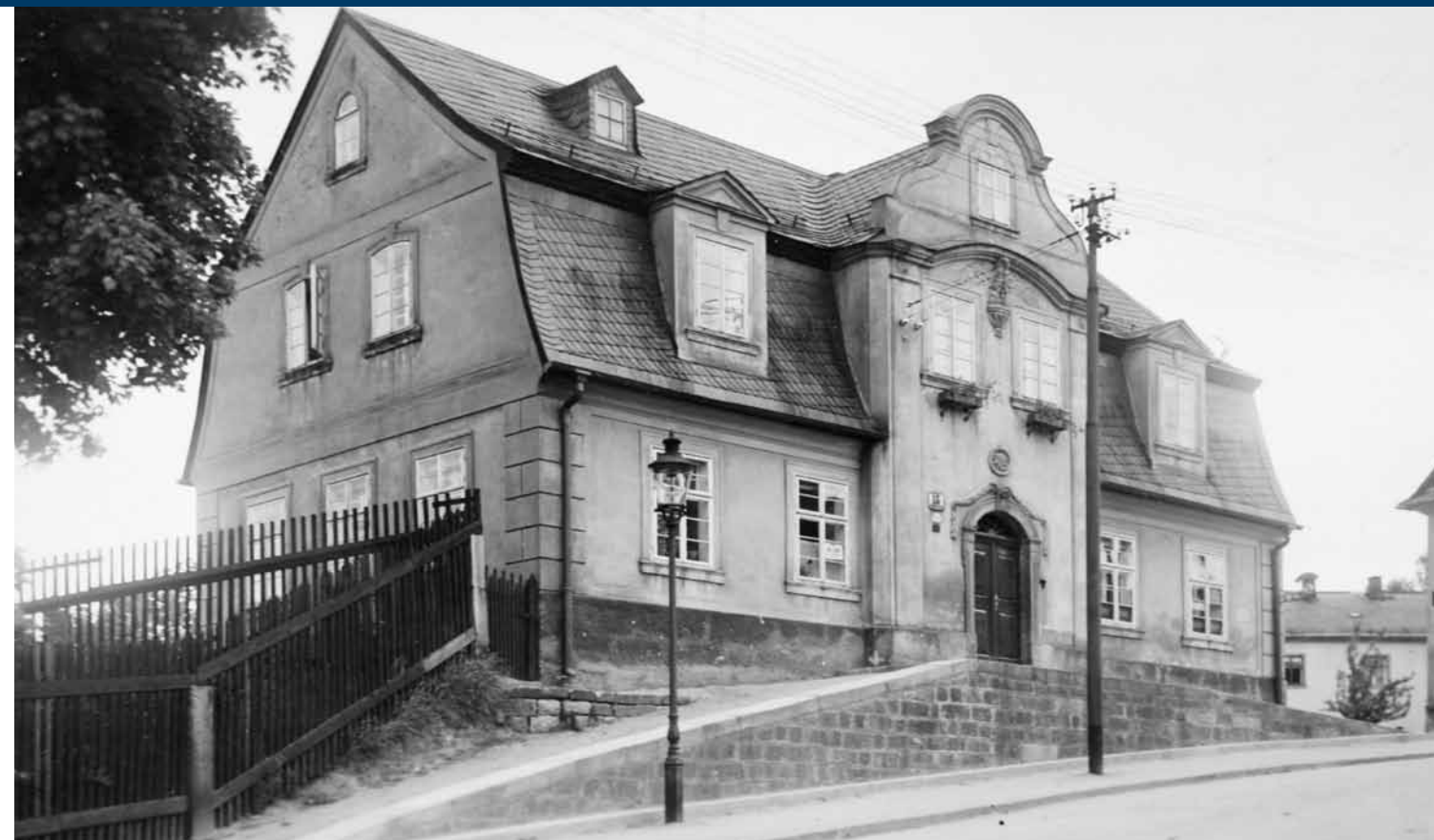
Historická fotografie z počátku 30. let 20. století, na níž dům kryje ještě původní břidlicová střecha.
