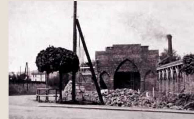
VERLAUF DES KIRCHBAUS, FRÜHJAHR BIS SOMMER 1938
