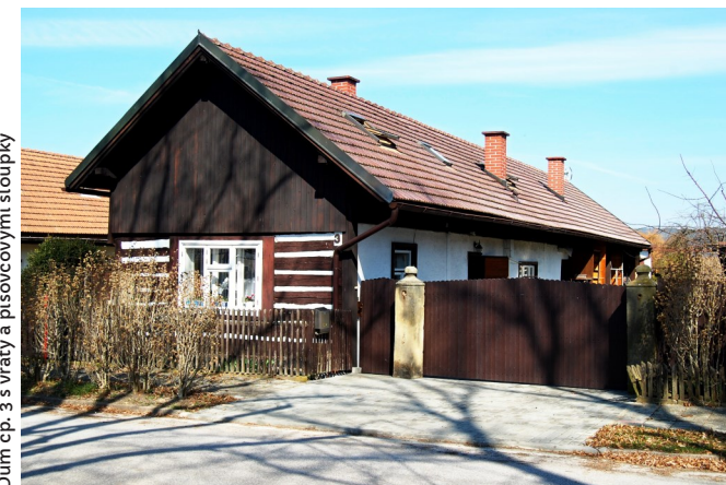
Dům čp. 3 s vraty a písčivými sloupky
