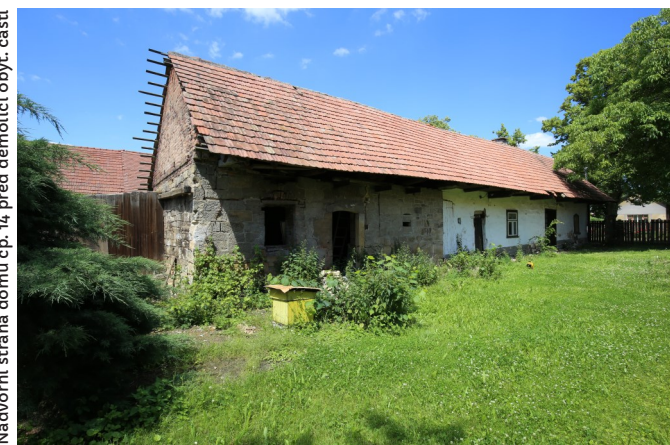
Nádvorní strana domu čp. 14 před demolicí obyč. částí
