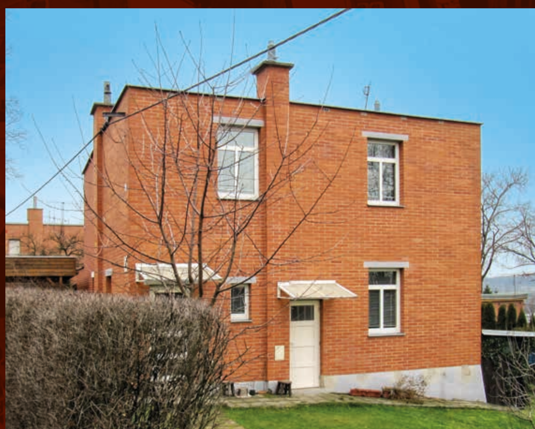
Zlín, typový dvojdomek v zástavbě obytné čtvrti Letná / Zlín, typical duplex house in the "Letná" residential area
