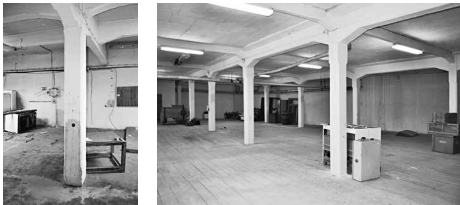
Obr. 8 Železobetonové nosné konstrukce dvou hal z let 1915–1920 – vlevo hala „A“, opravo hala „B“
