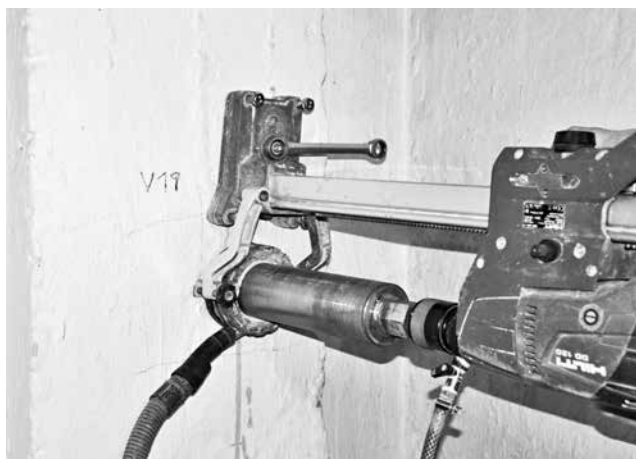
Obr. 4 Odběr vzorku betonu o průměru 75 mm jádrovým ortáním (foto P. Cikrle)
