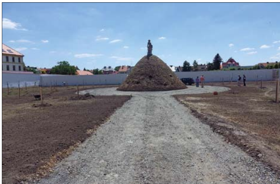
Obr. 19: Připravená podkladová vrstva pro nové založení mlatové cesty – Kožtná zahrada v Kroměříži. (Foto L. Křesadlová, 2014)
