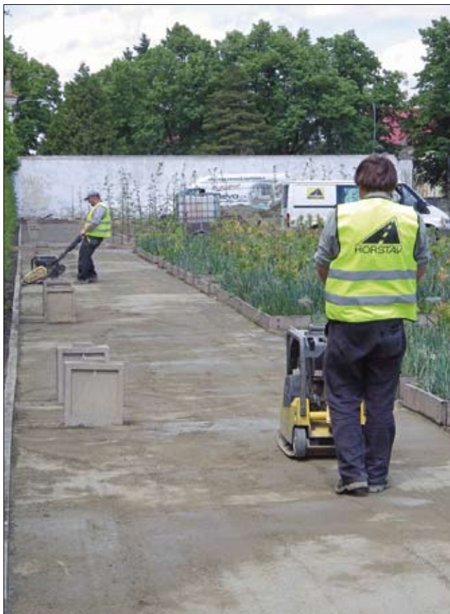
Obr. 21: Opakované vlhčení a hutnění s vrchní vrstvy patří k nejdůle- žitějším operacím při zakládání mlatových povrchů – Koětná zahradá v Kroměříži. (Foto L. Křesadlová, 2014)
