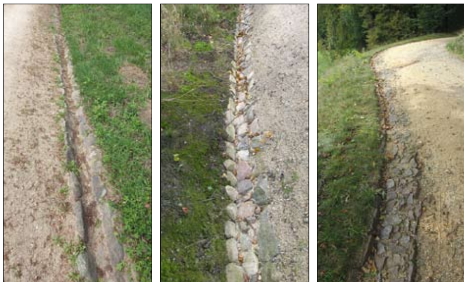
Obr. 5: Různé typy proků podélného odvodnění v parcích zakládaných knížetem Hermannem von Pückler-Muskau – Muskau a Branitz. (Foto L. Křesadlová, 2015)
