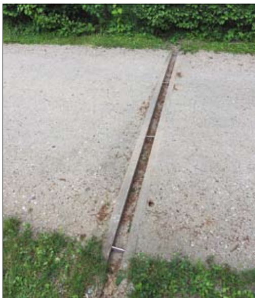
Obr. 13: Odvádění přebytečné vody kanálky pod okrajem cesty ve svažitých partiích v barokní zahradě Bobolí ve Florencii. (Foto L. Křesadlová, 2011)
