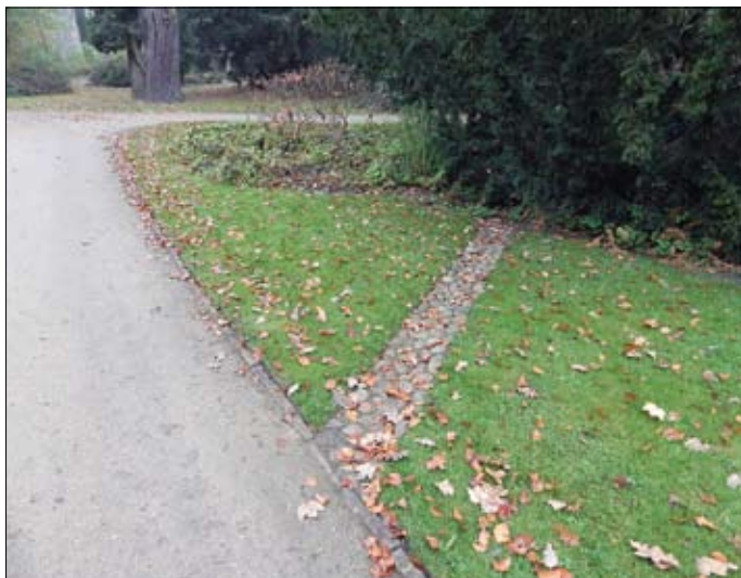
Obr. 17, 18: Různě typy příčného i podélného odvodnění cest ve svažitéch partiích zahrad Sanssouci o Postupimi. (Foto L. Křesadlova, 2014)
