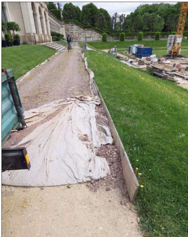
Obr. 22: Ochrana konstrukce mlátového chodníku při pojezdu těžší mechanizace v rámci rozsáhlé obnovy barokní zahrady Großsedlitz za pomoci textilie a vrstvy hrubého štěrku. (Foto L. Křesadlova, 2015)
