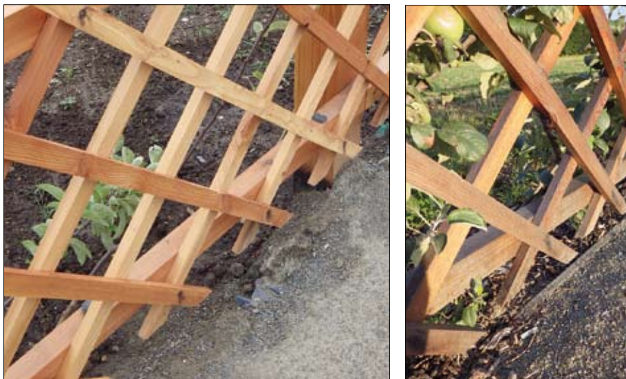
Obr. 11: Okraje mlatových cest vyvýšené nad terénem mohou být bez použití obrub nestabilní. Vlevo stav před dodatečnou instalací dřevěných obrub, vpravo po instalaci – Kočetná zahrada v Kroměříži. (Foto L. Křesadlová, 2014)
