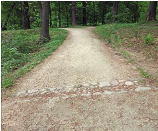
Obr. 6: Příčný kamenný žlábek odvádí přebytečnou vodu do navazujícího porostu – Muskau. (Foto L. Křesadlová, 2015)
