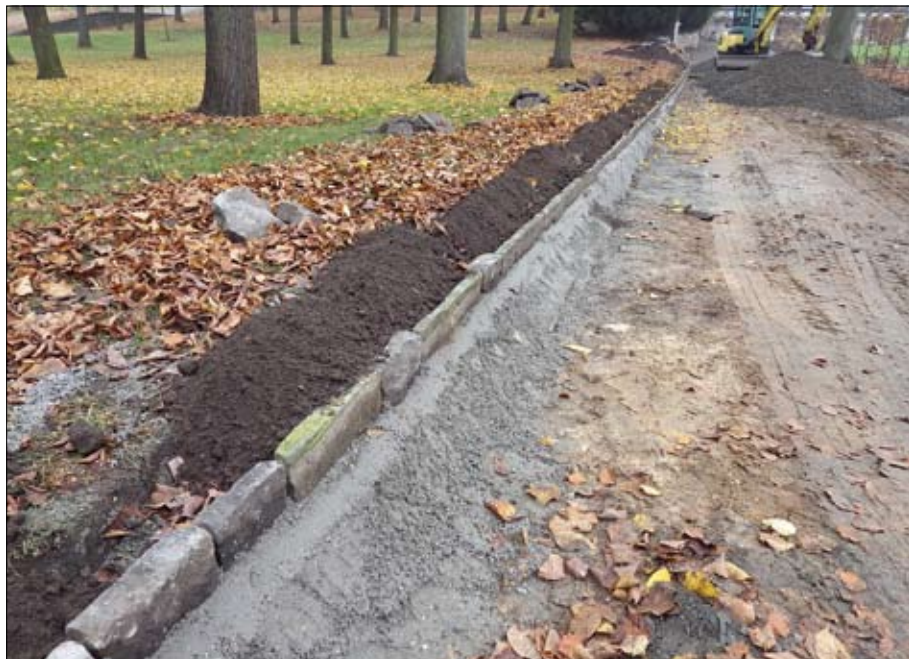
Obr. 12: Obruba z plochých kamenů upevněná do betonu – Sanssouci, Postupim (Foto L. Křesadlová, 2014).
