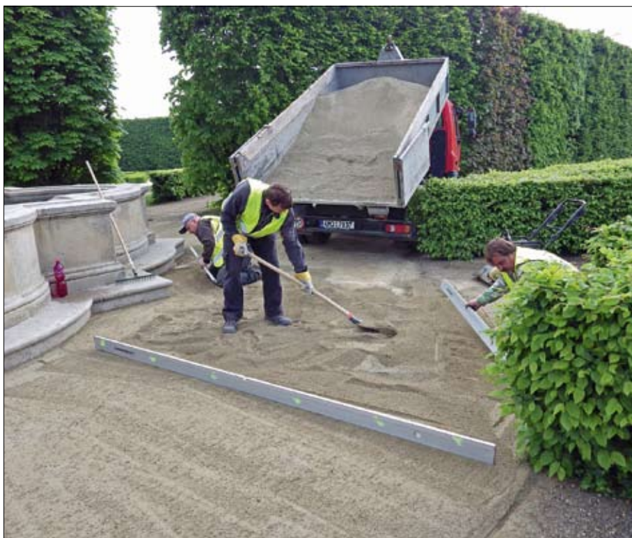
Obr. 20: Proces pokládky svrchní vrstvy mlatového povrchu – Květná zahrada v Kroměříži. (Foto L. Křesadlová, 2014)
