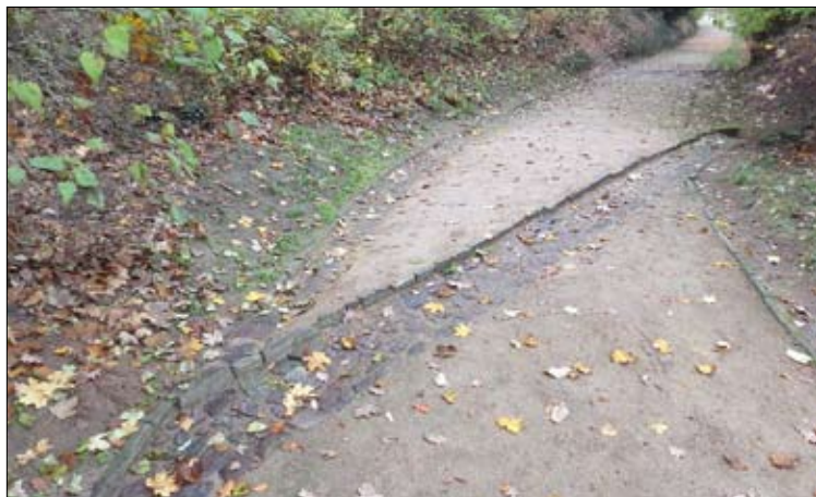
Obr. 15, 16: Různě typy příčného i podélného odvodnění cest ve svažitéch partiích zahrad Sanssouci v Postupimi. (Foto L. Křesadlová, 2014)
