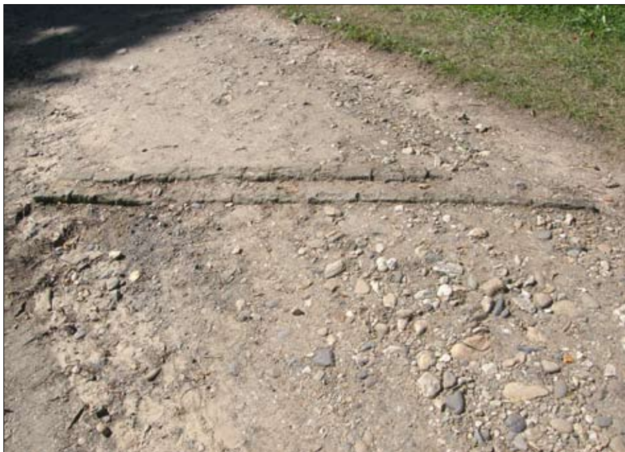
Obr. 9: Tato cesta vyžaduje obnovu, neměly by při ní ošak dojít ke ztrátě původních prvků příčného odvodnění. (Foto L. Křesadlová, 2010)
