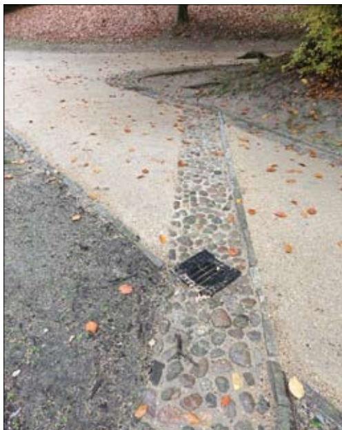
Obr. 15, 16: Různě typy příčného i podélného odvodnění cest ve svažitéch partiích zahrad Sanssouci v Postupimi. (Foto L. Křesadlová, 2014)
