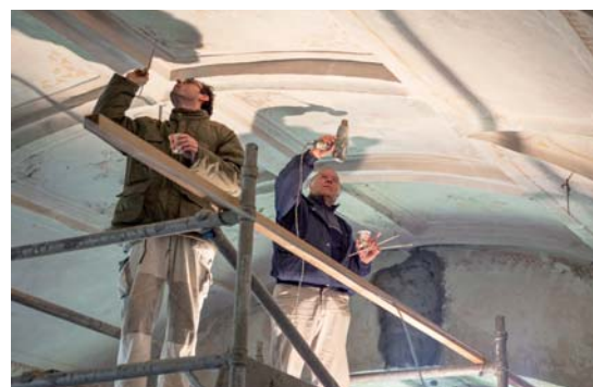
Praktická část kurzů řemeslné obnovy na zámku v Brtnici
