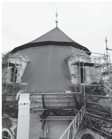
Rekonstrukce střech na zámku ve Vranově nad Dyjí
