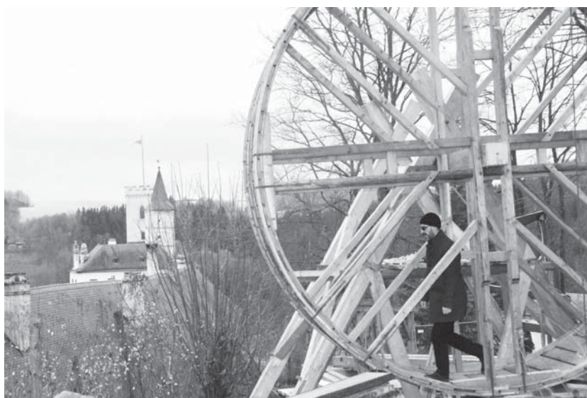
Dobrovolníci při obnově věže Jakobínka na Rožmberku
