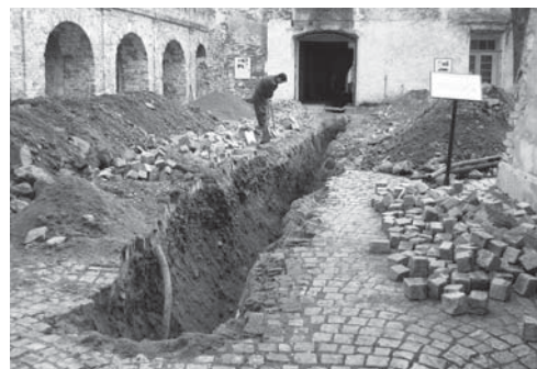
Hrad Veveří, výkopy pro vodovodní potrubí na arkádovém nádvoří
