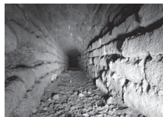
Novověký cihlový kanál tvořící součást rozsáhlého odvodňovacího systému
