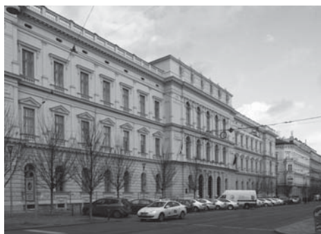
Obnovené průčelí Ústavního soudu v Brně
