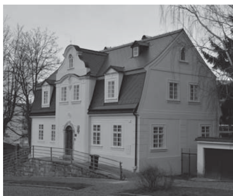
Dům U Pelikána v Liberci po obnově
