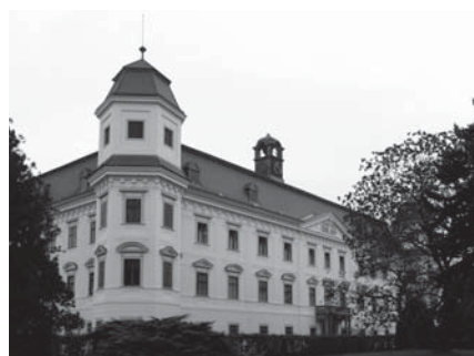
Obnova hlavního průčelí zámku v Holešově byla nominována na cenu Patrimonium pro futuro
