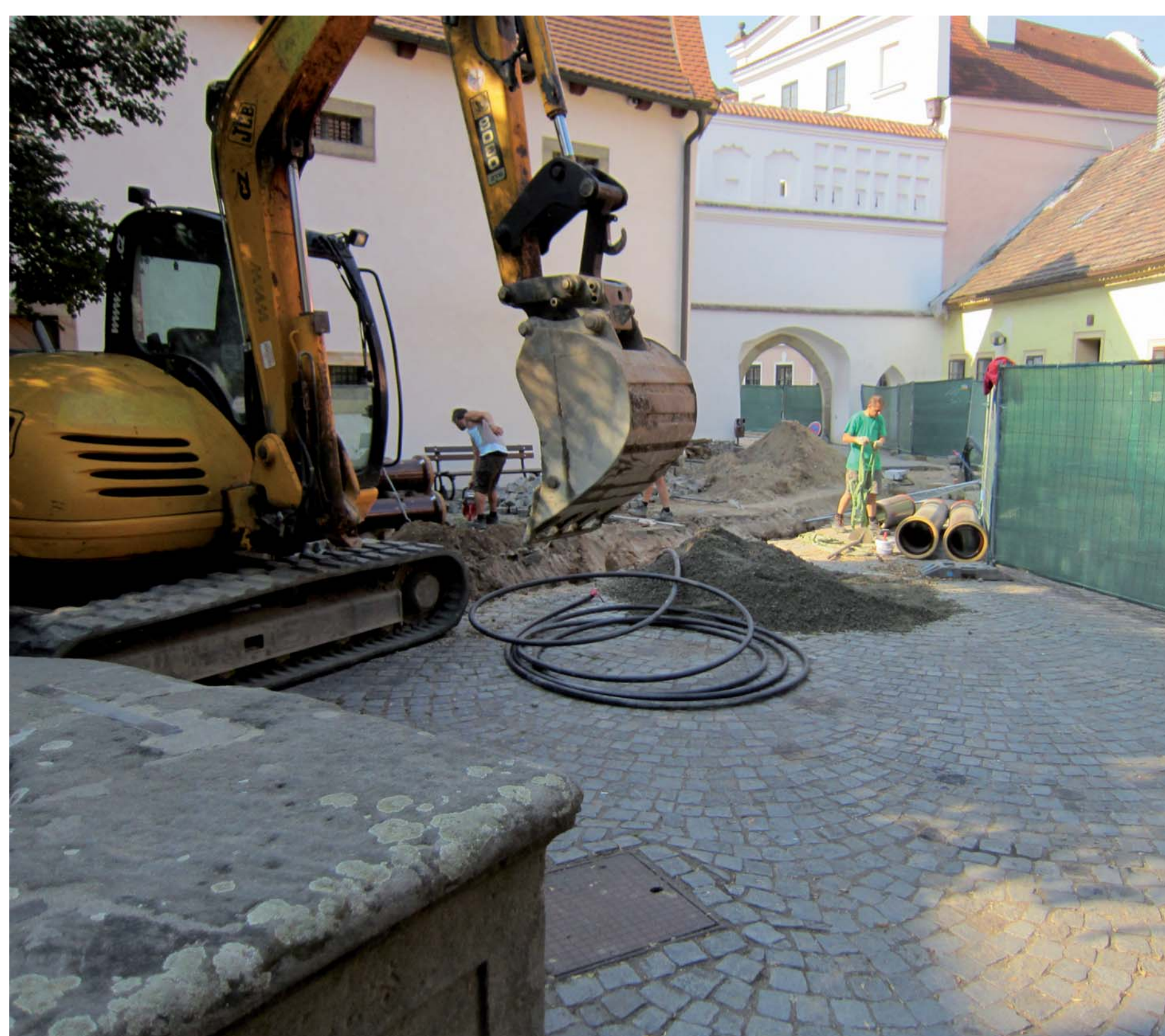
Jižní větev výkopu pro kanalizaci probíhající mezi kašnou a kulisovou bránou
