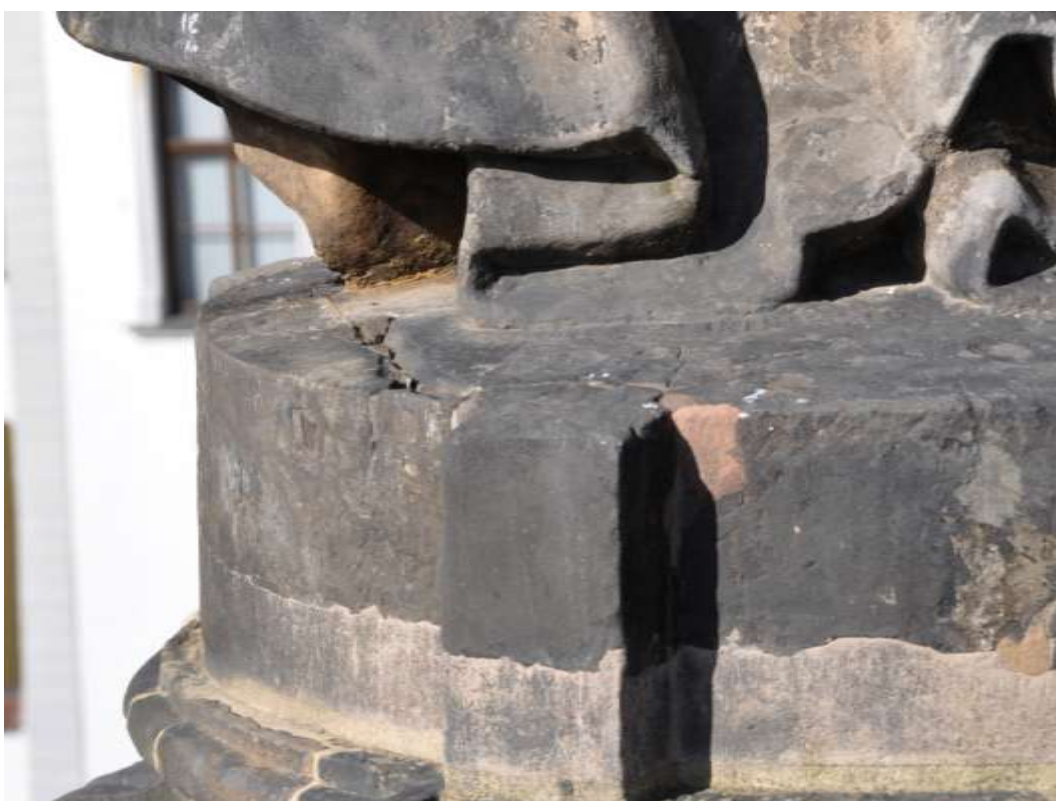
Obrázek 12: Třetí patro sloupu, socha sv. Anny, poškození v přední části plintu
