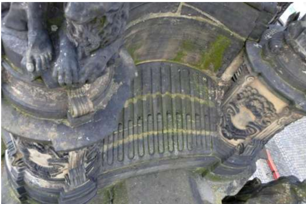
Obrázek 7: Architektura druhého patra sloupu s hojným biofilmem s převažující zelenou řasou
