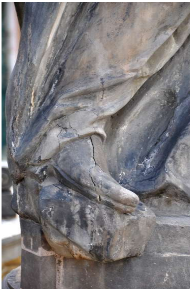
Obrázek 13: Třetí patro sloupu, socha sv. Jáchyma, opětovné poškození v minulosti lepené a doplňované spodní části nohy a drapérie
