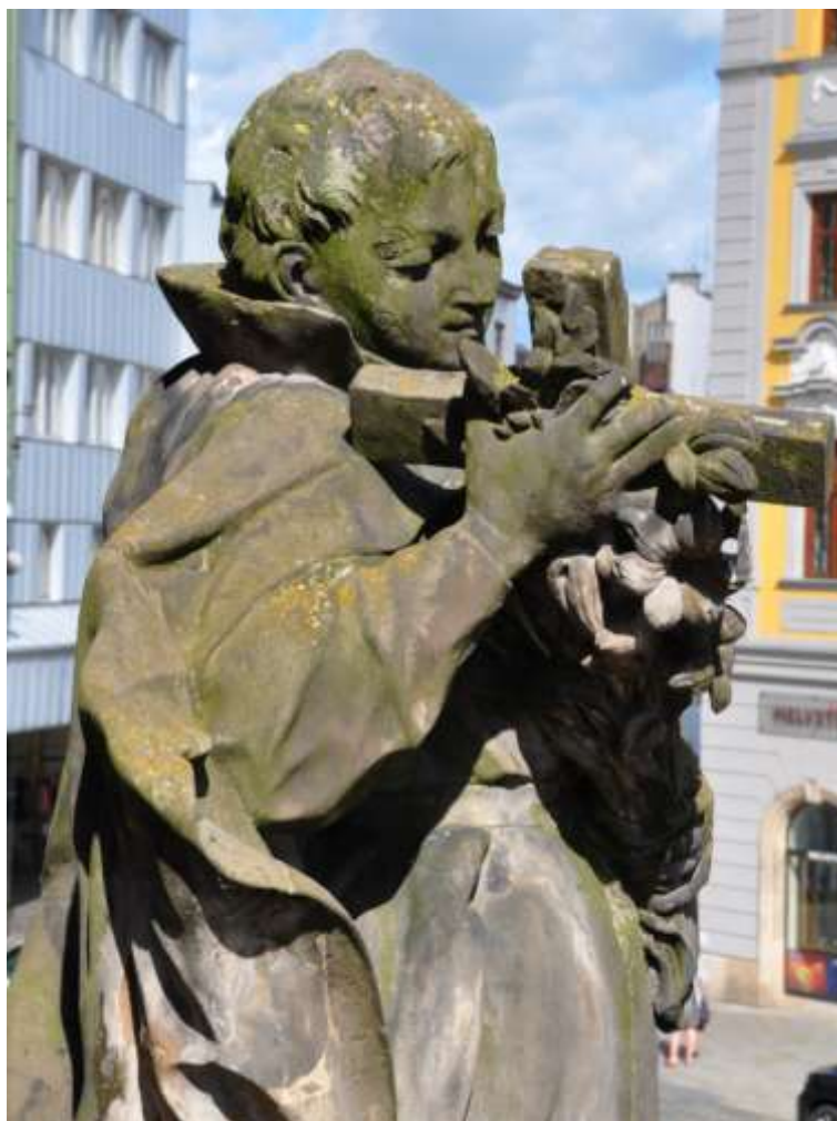
Obrázek 22: První patro sloupu, socha sv. Aloise Gonzagy patří díky silnému zavlhčení a severní orientaci mezi nejvíce kolonizované sochy nižšími rostlinami (řasami a lišejníky)
