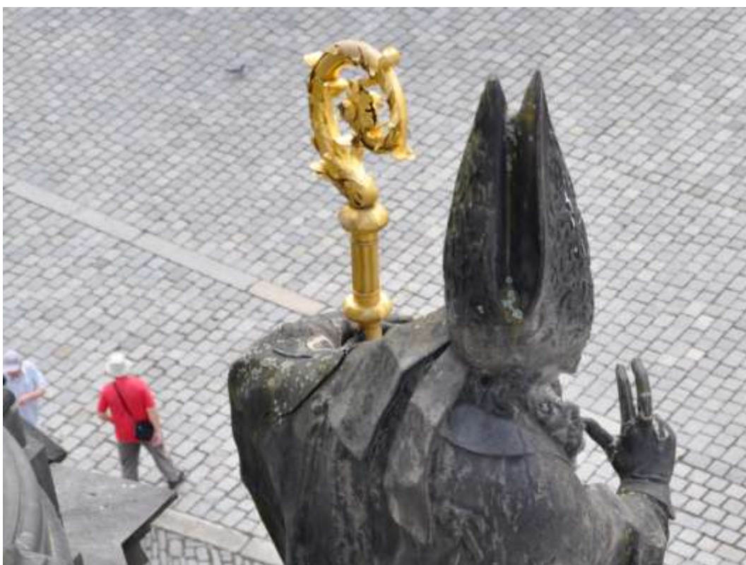
Obrázek 15: Druhé patro sloupu, socha sv. Metoděje, oprava levé paže světce v oblasti ramene je narušena velkou trhlinou
