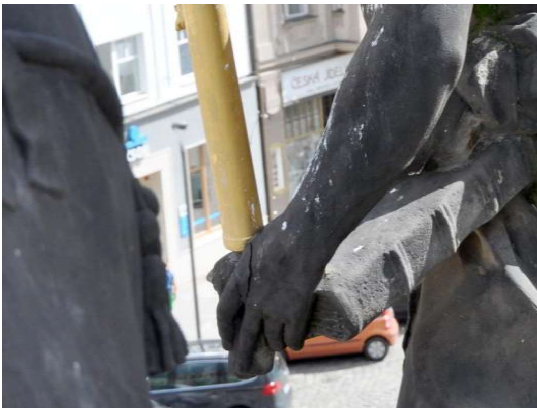
Obrázek 18: Třetí patro sloupu, socha sv. Jeronýma, prasklinou je poškozena také ruka světce
