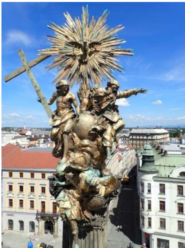
Obrázek 26: Vrcholové sousoší Nejsvětější Trojice, přestože od posledního zásahu došlo k poměrně výrazným vizuálním změnám povrchu, sousoší nevykazuje závažnější poruchy
