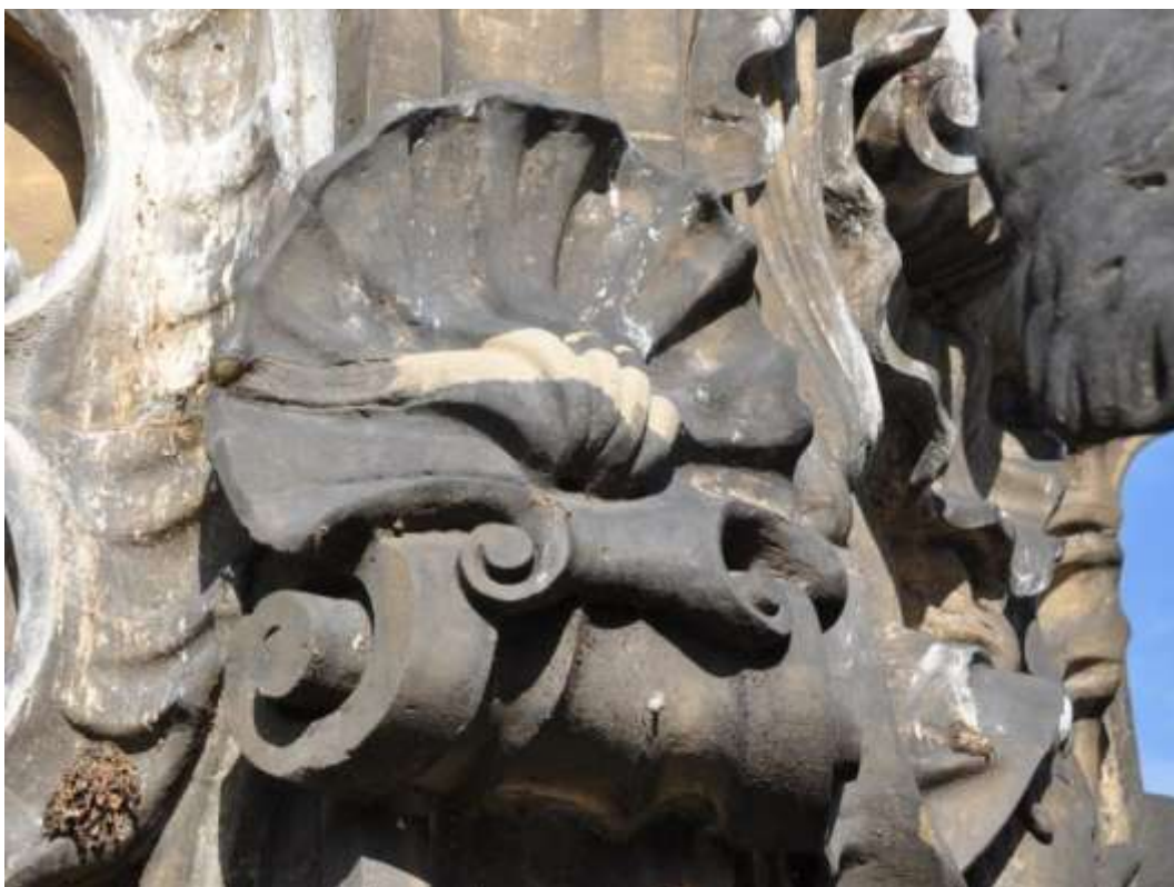
Obrázek 8: Ozdobná mušle na nároží vrchní části třetího patra sloupu, patinace doplňku je smyta a doplněk provedený ve světlém tmelu rušivě vystupuje z okolního kamene s tmavou krustou
