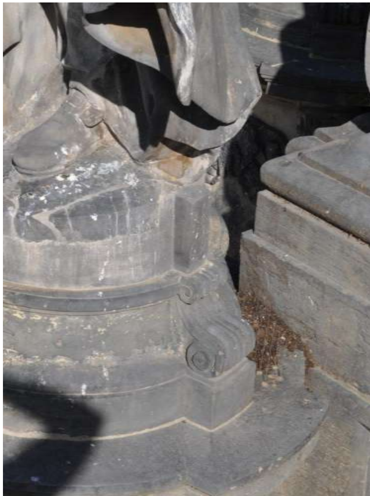
Obrázek 2: Třetí patro sloupu, detail prostoru za podstavcem sochy sv. Jáchyma, na horizontálních plochách architektury se hromadí exkrementy a další materiál donesený ptáky, zábrany proti ptactvu neplní svoji funkci
