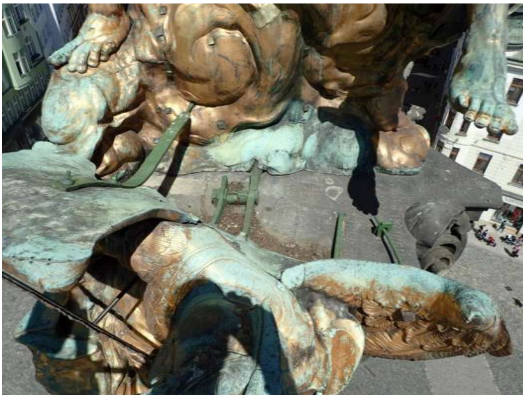
Obrázek 28: Vrcholové sousoší Nejsvětější Trojice, povrchová úprava viditelných konstrukčních prvků vrcholového sousoší je bez poškození
