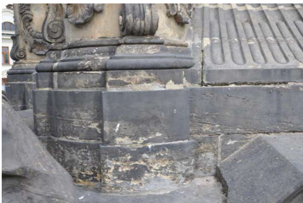
Obrázek 4: Druhé patro sloupu, poškozené spárování pod ukloněnou partií architektury, níže na snímku je patrná degradace kamene na vertikálních plochách architektury nad římsou
