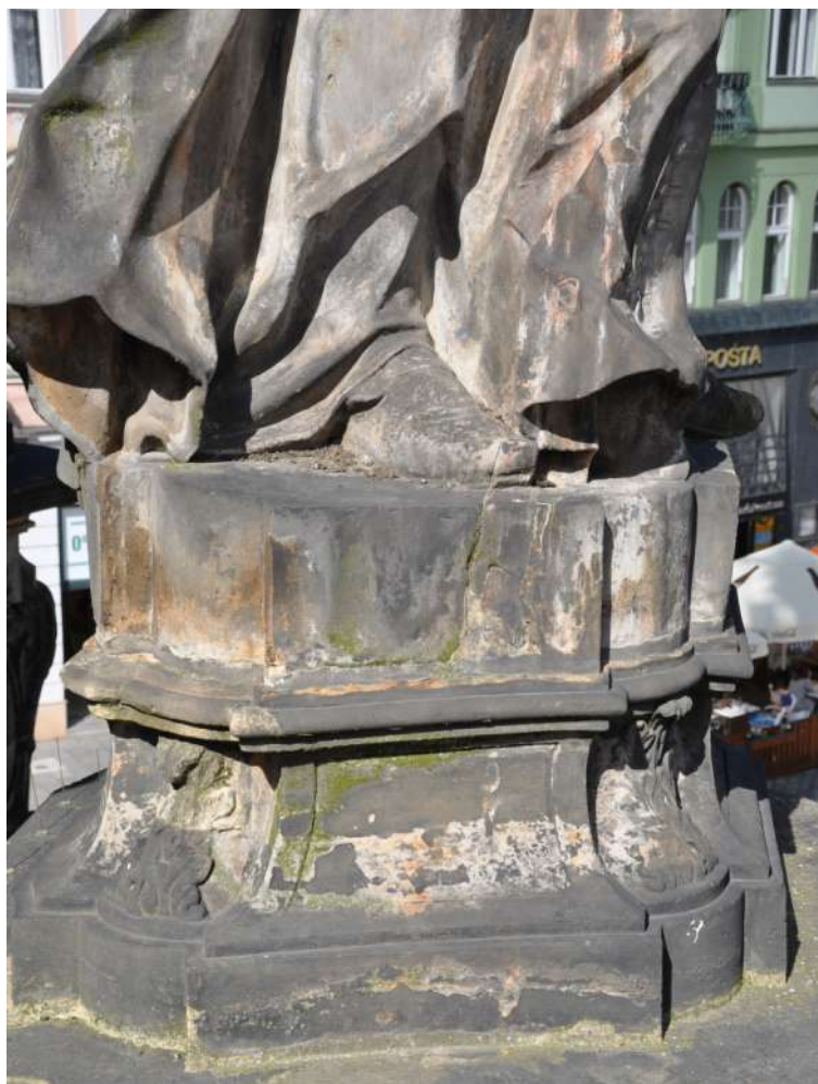
Obrázek 23: Druhé patro sloupu, spodní partie sochy sv. Jana Nepomuckého, partie nad horizontálními plochami (v tomto případě nad hlavicí podstavce) jsou často postižena povrchovou korozí kamene, patrné je též zrzavě hnědé znečištění způsobené migrací degradačních produktů fermeže
