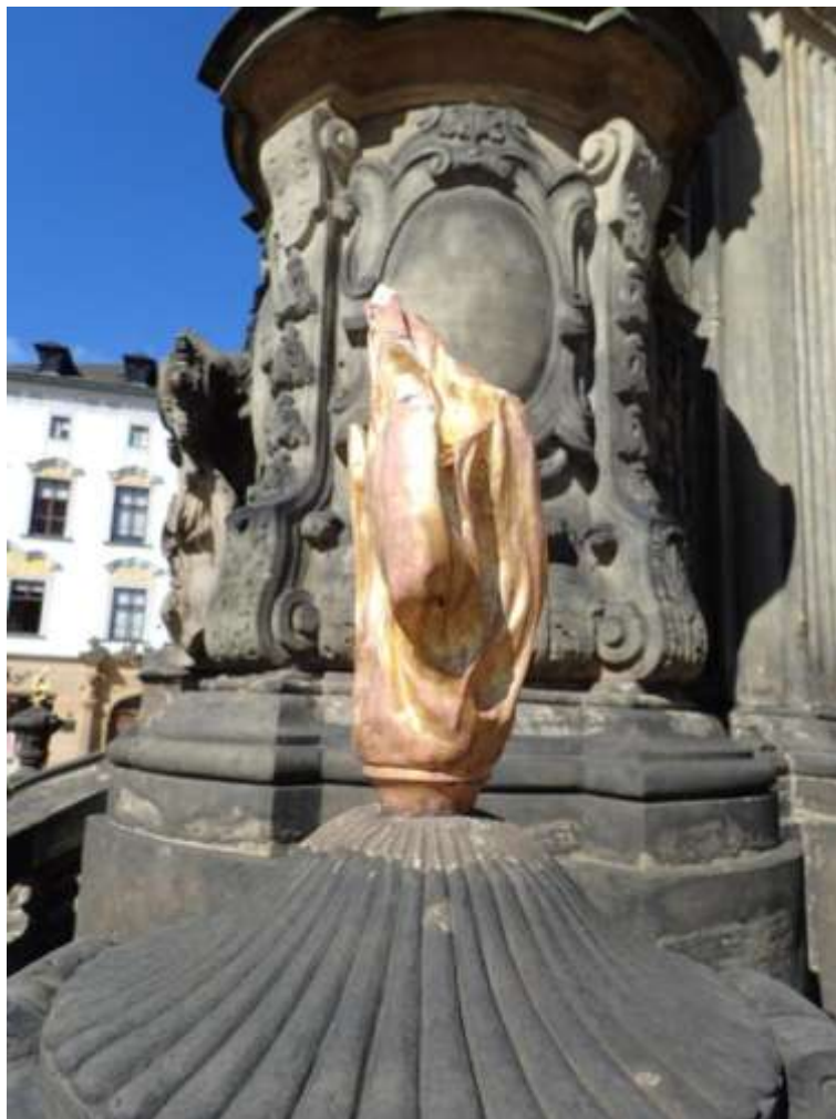
Obrázek 31: Zlacení plaménekův váz na balustrádě je narušené
