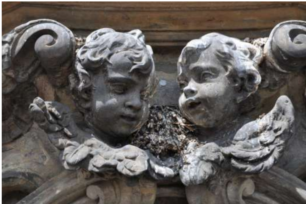
Obrázek 20: Druhé patro sloupu, hlavičky andílků nad kartuší s reliéfem apoštola Filipa, kromě znečišťování sloupu exkrementy ptáci na příhodných místech sloupu hnízdí
