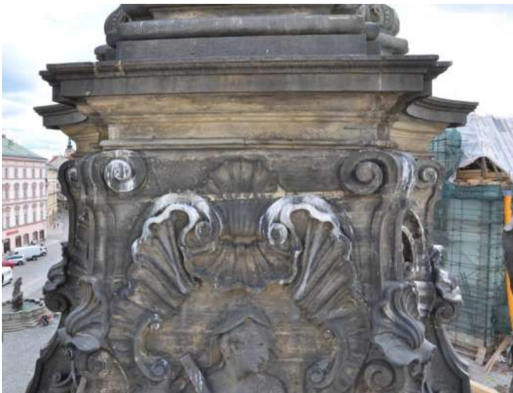
Obrázek 1: Třetí patro sloupu s reliéfem Naděje, vrchní části plastických prvků jsou silně znečištěné ptačími exkrementy
