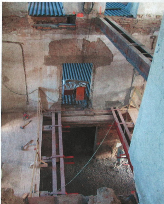
▲ Obr. 9 Průběh montáže stropu 1. a 2.NP (viditelná je původní dvojice nosníků)
