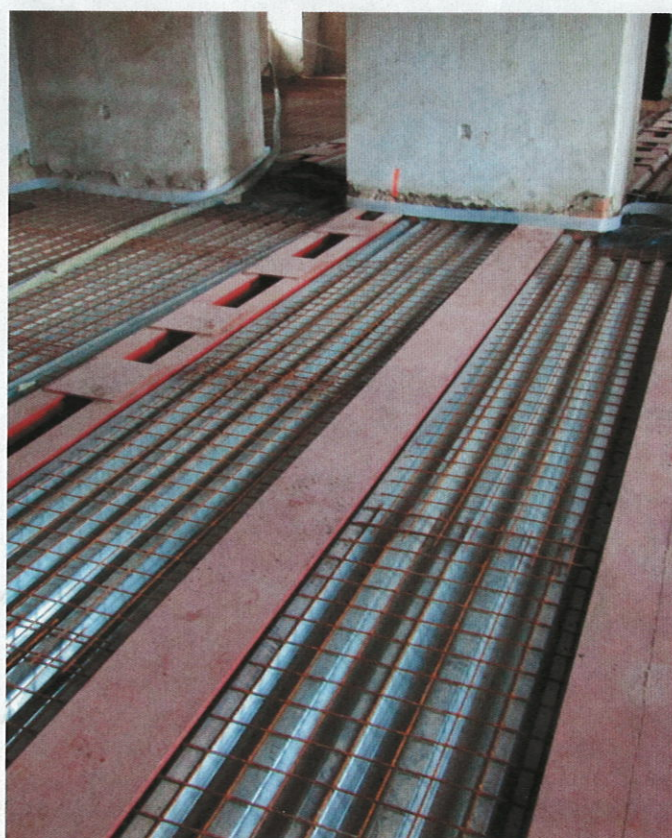
▲ Obr. 10 Průběh vyztužovacích prací
