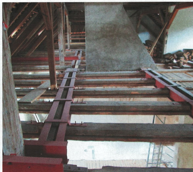
▲ Obr. 6 Příprava podlahy pro umístění technologií
