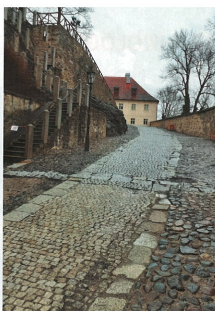
▲ Obr. 13 Historická přístupová komunikace po stavebních úpravách
