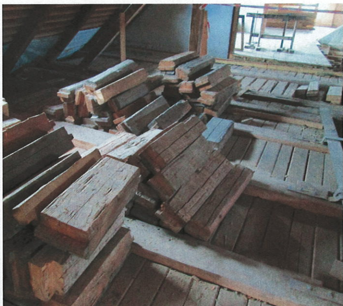
▲ Obr. 5 Stav po demontáži původního stropu
